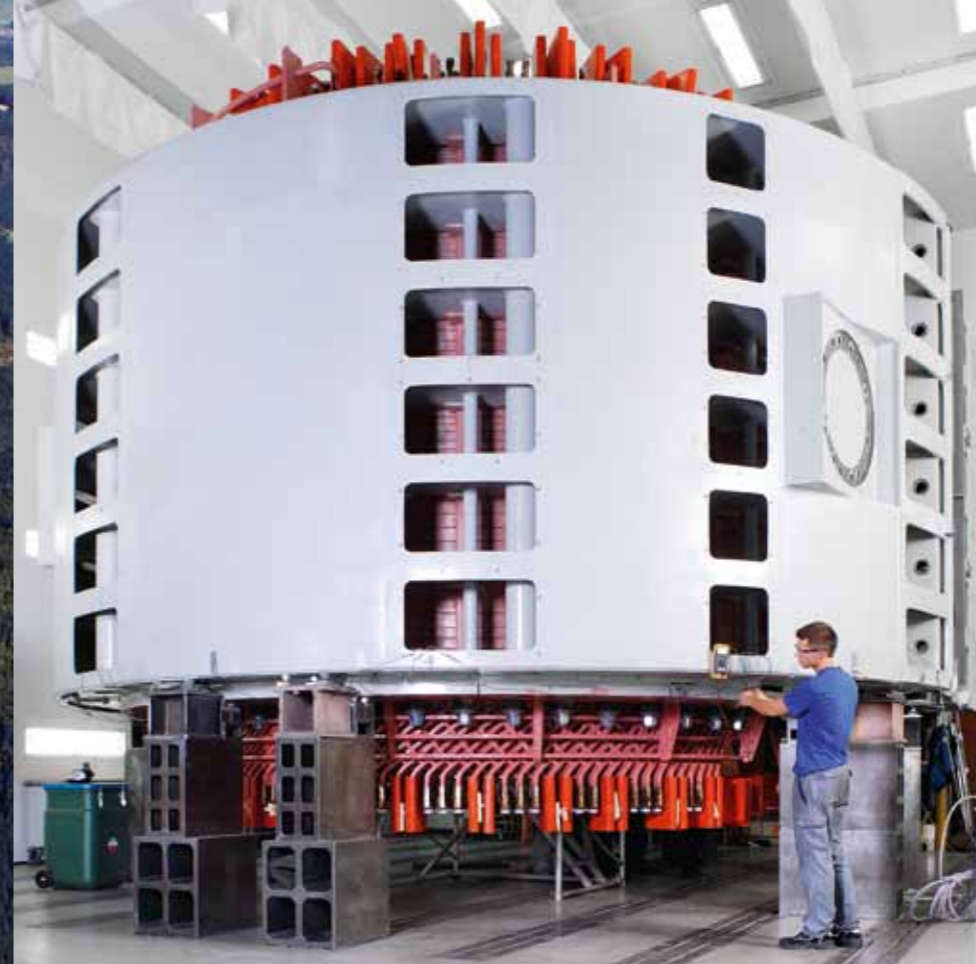
Modernisierungsarbeiten an einem der Generatoren in Wehr.
