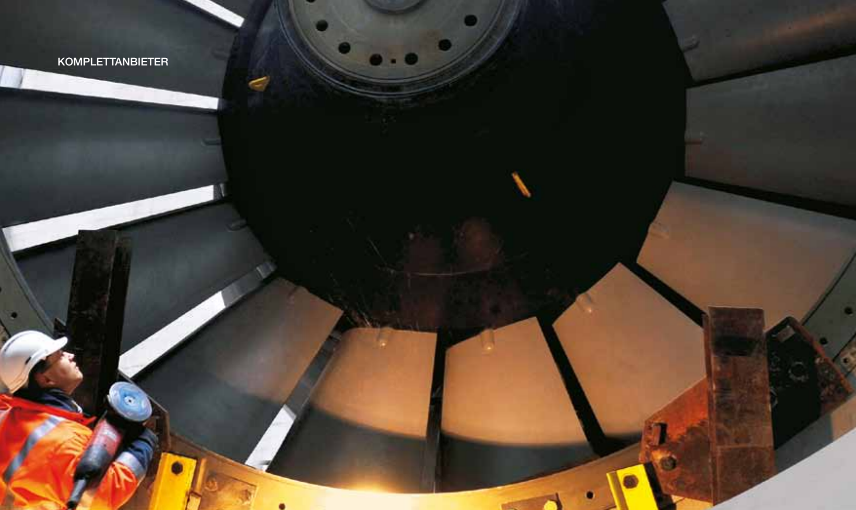
Leitschaufel des umfassend modernisierten Wasserkraftwerks Rheinfelden an der schweizerisch-deutschen Grenze.
