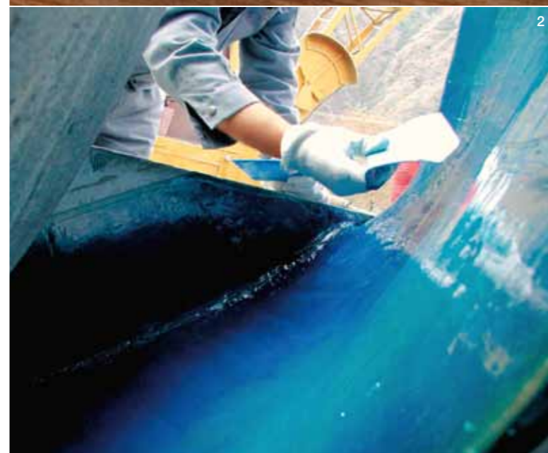
1&2 Die SOFTURB-Polymerbeschichtung zeichnet sich durch eine hervorragende Abriebfestigkeit aus. Sie kann herkömmlich, z. B. durch Bürsten oder Spritzen, aufgetragen werden. 3 Die Verbesserungen am Kraftwerk in San Men Xia steigern Effizienz, Ausgangsleistung und Erosionsbeständigkeit.
